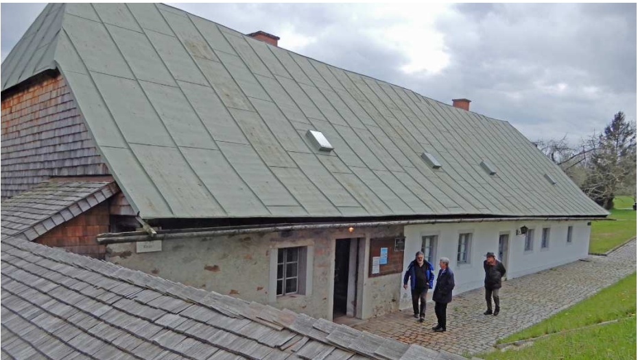
Bild 5: Das Hauptgebäude des Voithenberghammers: Schmiede und Gasthaus unter einem Dach
