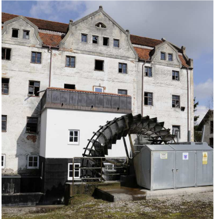
Neues Wasserrad der Mühle Spörerau bei Landshut
