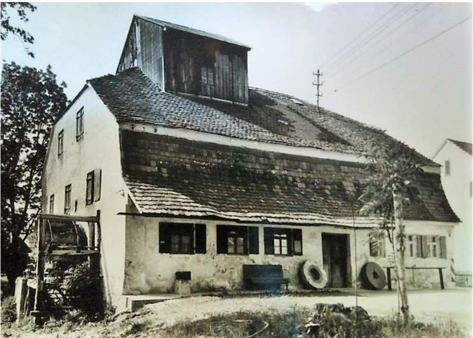
Die Mühle vor der Sanierung in den 1980er Jahren
