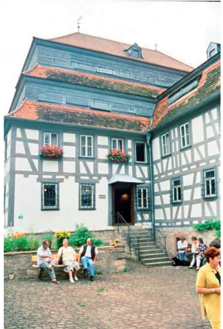
Die Papiermühle Homburg am Main mit ihrem imposanten zweifach gestuften Mansarddach, das seine Aufgabe, die Papiertrocknung, perfekt erfüllt.
